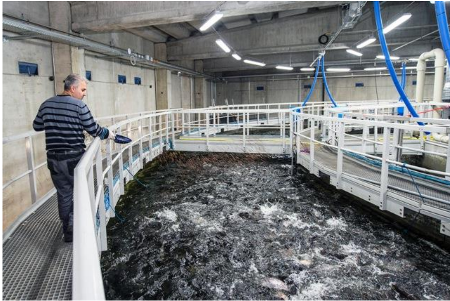
Figura 6: Un tanque circular grande (profundidad 6 m, diámetro 32.5 m) que forma parte de un RAS para salmones ( Swiss Alpine Fish )
