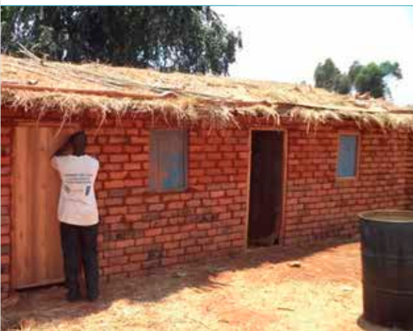
| Figure 3. Champignonnières en briques recouvertes d'un paillis
