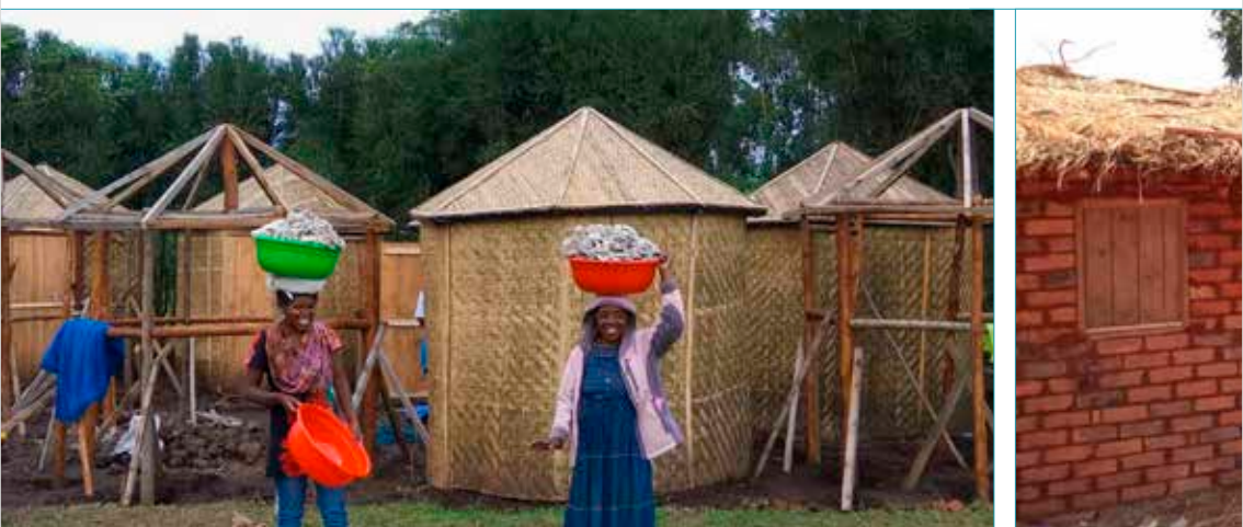
— Figure 2. Champignonnières à structure en bois recouvertes de nattes
