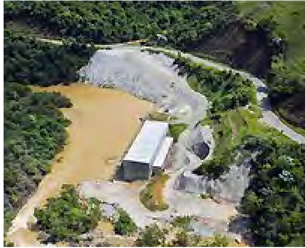
Fotografia N° 2. Casa de força da PCH Calheiros
