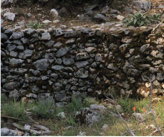
fig.12 Derbent yolu destek duvarları
