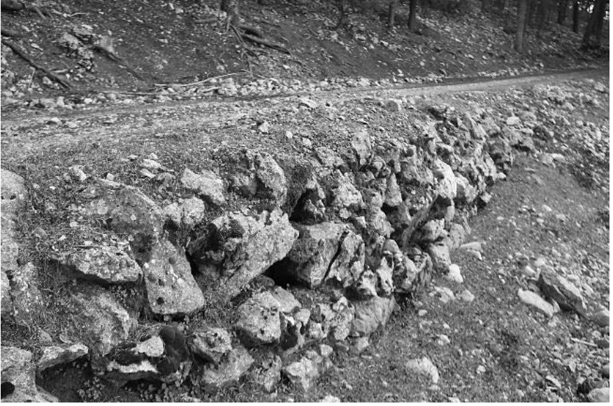
Res. 23. Duman Çeşmesi ve Duman Gediği arasındaki yolun istinat duvarları.
