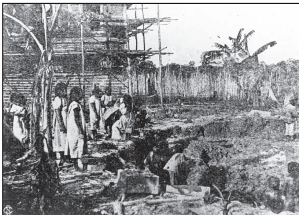
Chorrera – Trabajos de edificación
