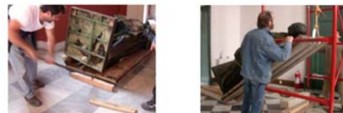
Εικόνα: Μεταφορά σε κυλιόμενο φορείο με κατρακύλια
