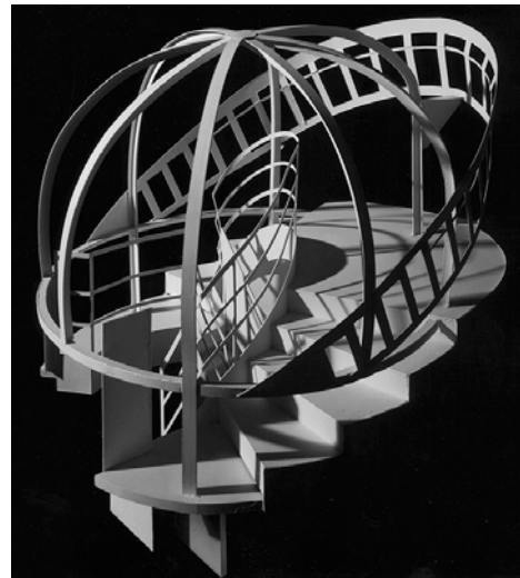
Εικόνα 5.17: Τρισδιάστατη αναπαράσταση του εσωτερικού του κεφαλιού του αγάλματος της Ελευθερίας
