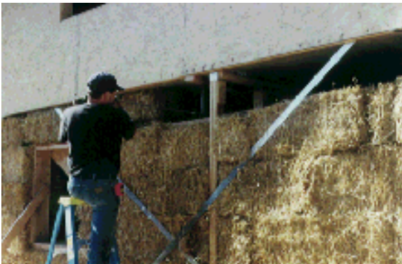
Εικόνα 3.2: Τοιχοποιία με δομικά στοιχεία από άχυρο
