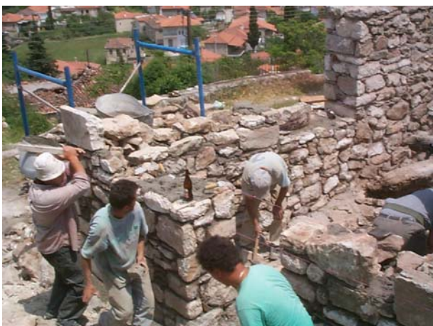
Εικόνα 2.26: Κατασκευή παραδοσιακής κατοικίας
