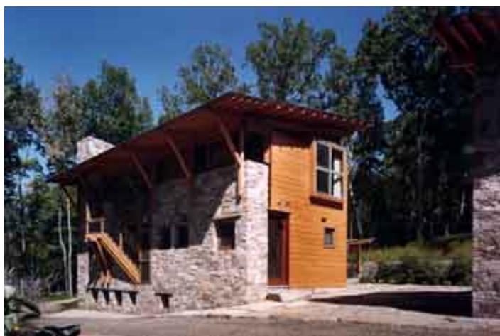
Εικόνα 3.1: Ξύλινη κατασκευή με όψη από λιθοδομή
