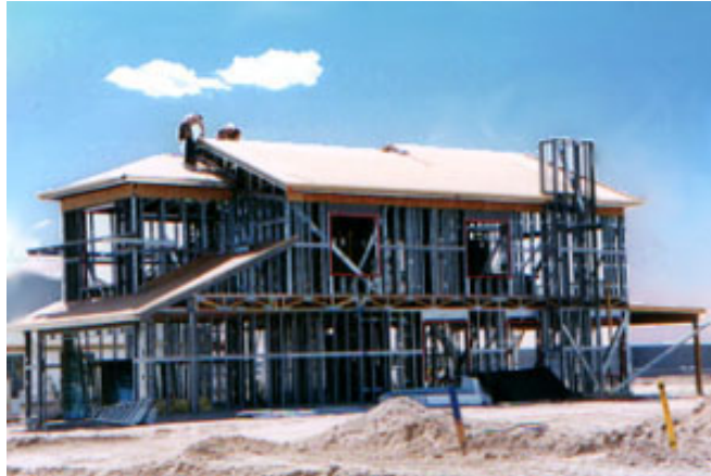
Εικόνα 3.3: Κατασκευή με μεταλλικό φέροντα οργανισμό
