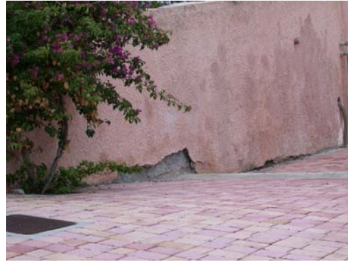
Εικόνα 3.21: Αποτελέσματα της ανερχόμενης υγρασίας σε εξωτερικό τοίχο της «Βίλας Σερπιέρι» (ΤΠΠΑ)
