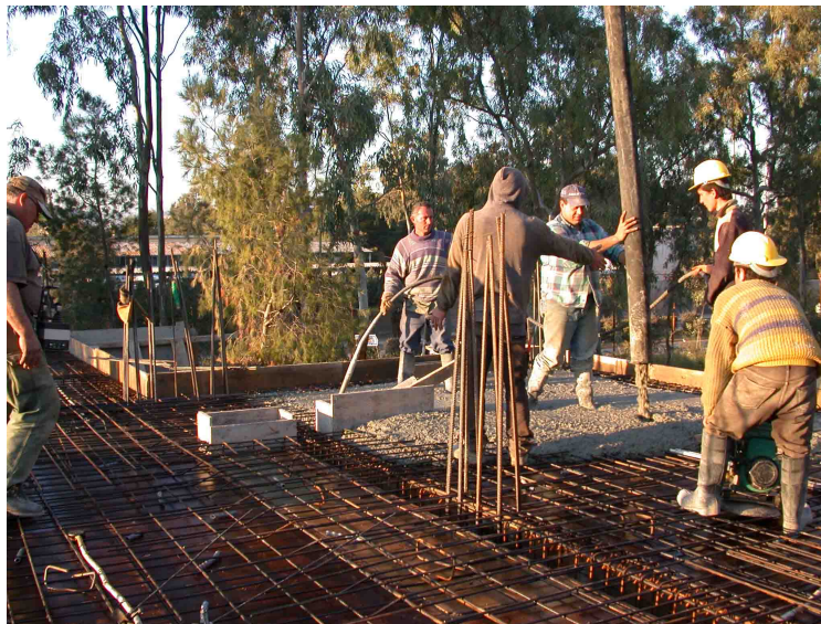
Εικόνα 13: Σκυροδέτηση πλάκας.
