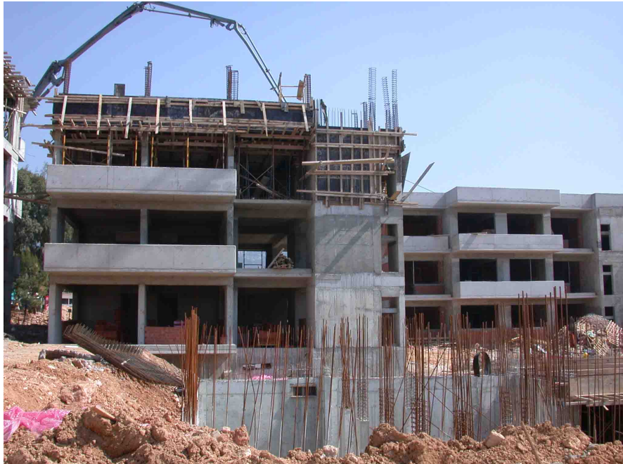
Εικόνα 10: Σκυροδέτηση σε εργοτάξιο.
