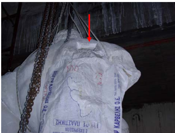
Εικόνα 3.20: Οπή συμπλήρωσης ζώνης γύψου από τον κορμό του έργου (Φάση 1)
