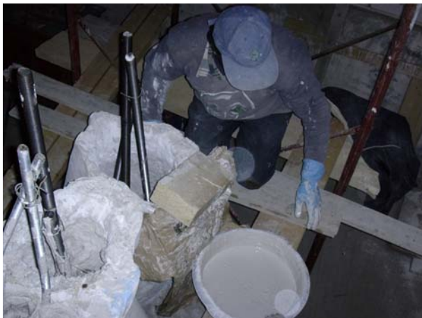
Εικόνα 3.16: Αναμονές του σπλισμού από τα πόδια και τον κορμό στήριξης του έργου
