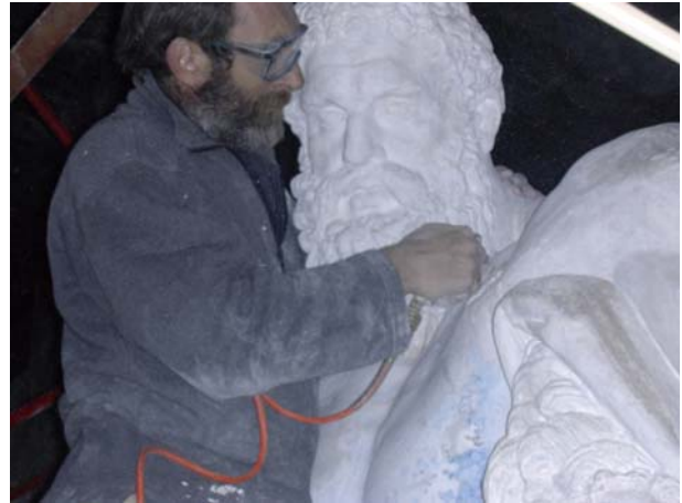
Εικόνα 3.28: Καθαρισμός λεπτομερειών με αέρα υπό πίεση
