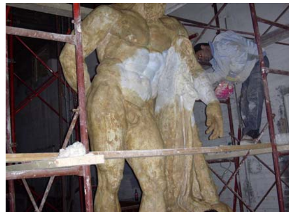
Εικόνα 3.35: Εργασίες πατίνας του έργου
