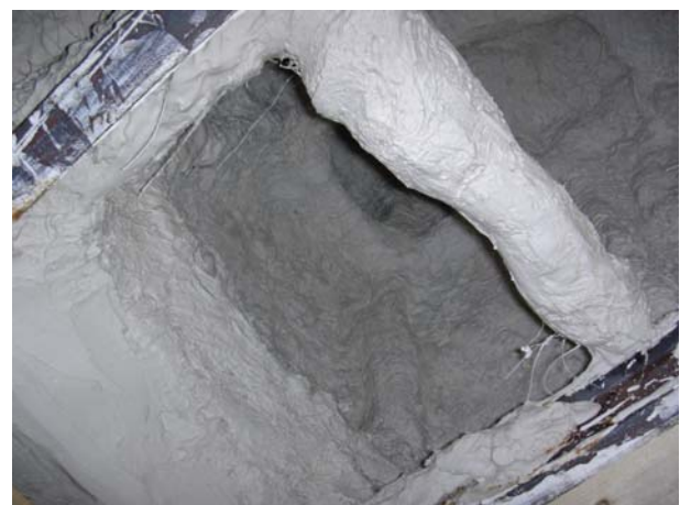
Εικόνα 3.13: Εσωτερική όψη του κορμού στήριξης του έργου. Ενίσχυση από ινοπλισμένη γύψο
