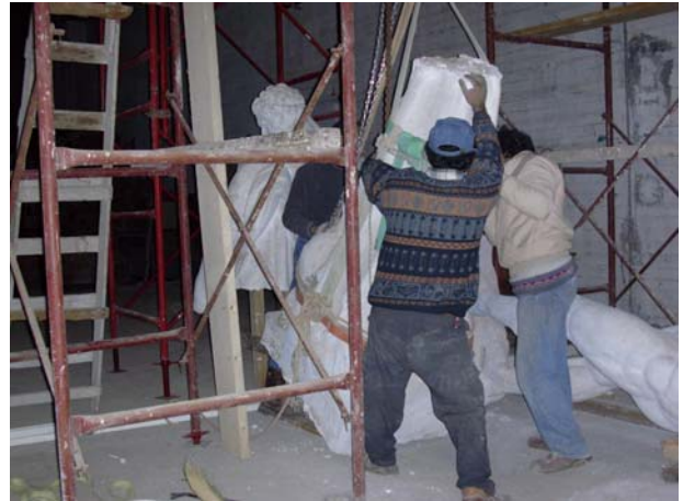
Εικόνα 3.5: Μετακίνηση της βάσης (Φάση 2) σε θέση εργασίας για την κατασκευή του σκελετού
