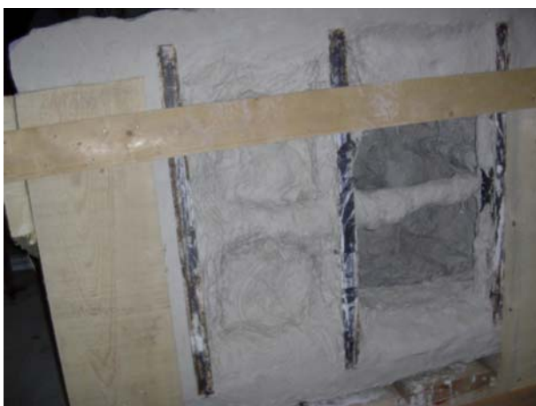
Εικόνα 3.12: Κάτω όψη της βάσης του έργου μετά την κατασκευή σκελετού ενίσχυσης
