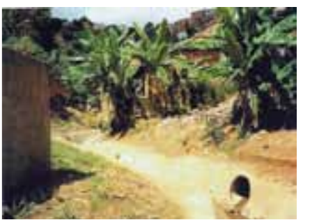
Córrego Coqueiral com canalização. Acervo Projeto Manuelzão
