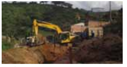
Canalização no córrego Av. Dois, junto a nascentes. Daniela Vieira, 2013.
