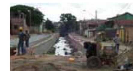
Canalização do Córrego Bom Jesus. Acervo Manuelzão Comunidade, 2010.
