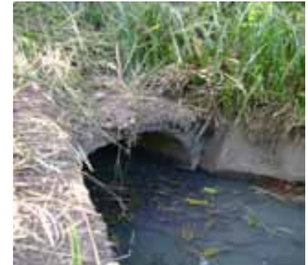
Canalização e esgoto no Córrego Mergulhão. Acervo Projeto Manuelzão, 2012.
