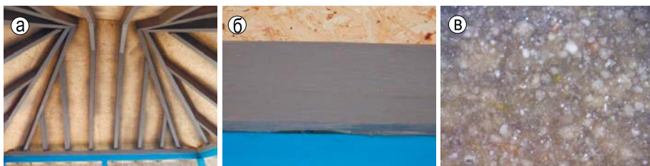
Рис. 9.48. Зовнішній вигляд внутрішніх несучих дерев'яних конструкцій шатрового даху альтанки (а) оброблених алюмосилікатним вогнезахисним покриттям після тверднення на дерев'яних поверхнях мауерлату (б) і скісних кроквах (а); мікроструктура захисного покриття (в)
