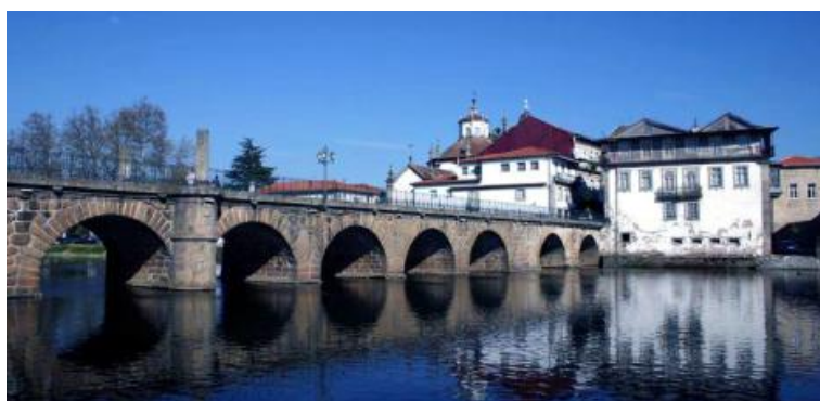
Fig. 9 – Ponte de Chaves (I d.C.)
