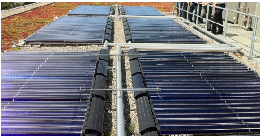
Abb. 1: Thermische Solaranlage flach auf dem Dach montiert
