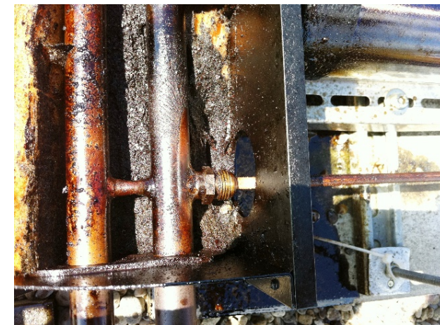
Abb. 3: Verschmutzungen und zähflüssige Schicht im Innenrohr
