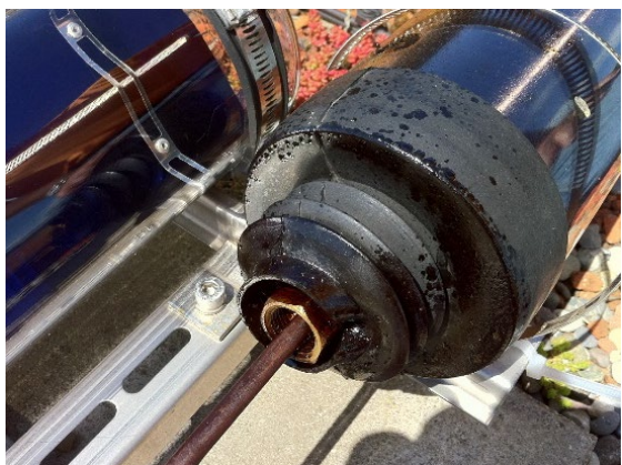
Abb. 2: Prüfen der Kollektor-Röhren von Innen
