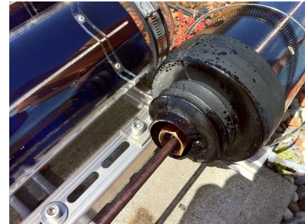
Abb. 2: Prüfen der Kollektor-Röhren von Innen
