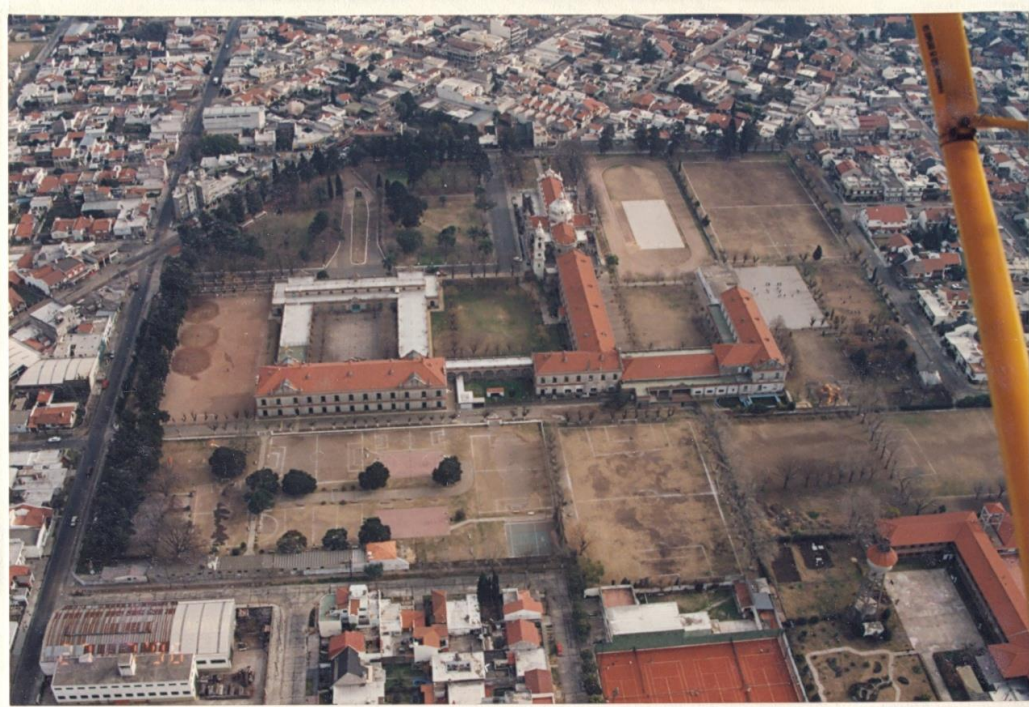
Figura 3. Foto de la vista aérea de la obra escolar Don Bosco. Centro de Ex alumnos. Archivo Fotográfico.
