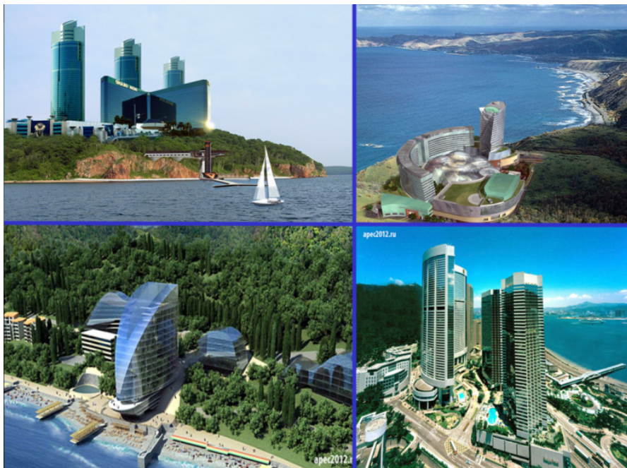
Рис. 8. Строящийся гостиничный комплекс во Владивостоке
