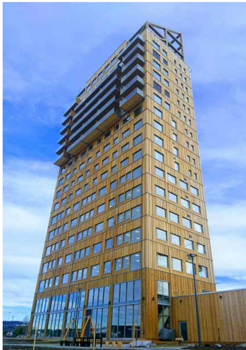
Mjøstårnet, največja lesena zgradba na svetu, stoji v mestu Brumunddal na Norveškem, ima 18 etaž in v višino meri več kot 85 m, avtor fotografije: dr. Igor Gavrič
