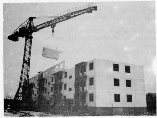
ZGRADA VO IZGRADBA A BUILDING UNDER CONSTRUCTION
