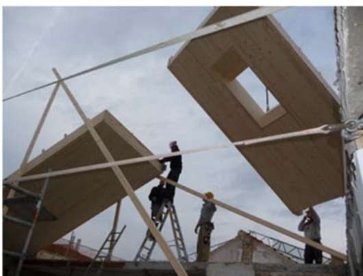
Figure 2. Installation of the pre-fabricated roof elements. Photo: kämpfen für architektur ag
