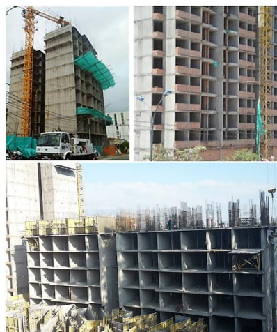
Figura 1. Edificaciones en muros de concreto reforzado, ciudad de Bucaramanga Fuente: Grupo de Investigación en Materiales y Estructuras de Construcción INME-UIS
