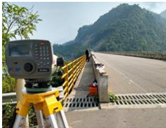
Figura 2. Procedimiento de medición del puente el Tablazo
