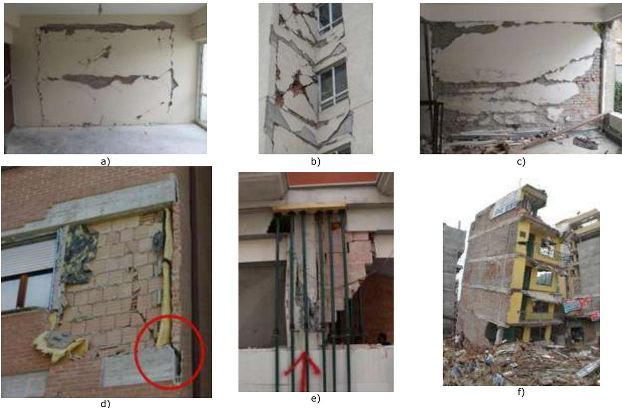
Figura 1 - Exemplos de danos observados em painéis de alvenaria ou causados pela presença de painéis de alvenaria em estruturas de betão armado: a) destacamento do painel de alvenaria (Varum *et al.* 2017); b) fissuração diagonal (Varum *et al.* 2017); c) deslizamento no centro do painel (Varum *et al.* 2017); d) colapso para fora-do-plano; e) mecanismo de pilar-curto; e f) mecanismo de piso-flexível (Varum *et al.* 2017).
