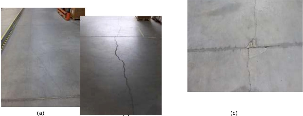
Figura 2.2 - Exemplos de anomalias/ danos identificados no pavimento existente: (a) fissuração ligeira, (b) fissuração profunda e (c) desagregação e empolamento das faces de juntas de indução de fendas
