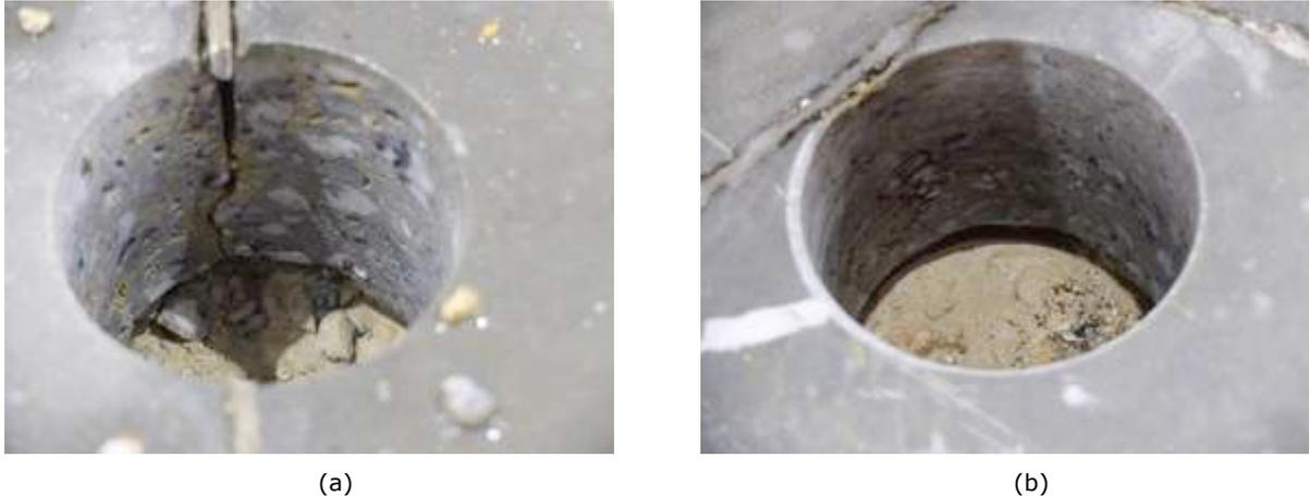
Figura 3.6 – Folgas observadas entre a base da laje térrea e o terreno: (a) 15mm e (b) 18mm
