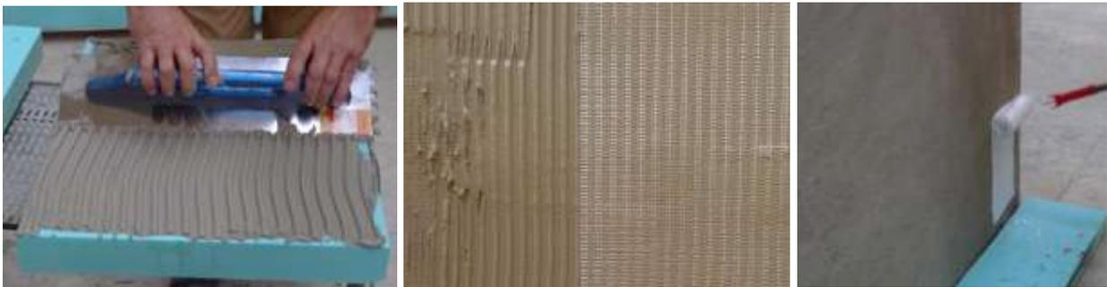
Figura 1: Execução de Sistema ETICS; à esquerda, material de colagem em placa de isolante térmico; ao centro, camada de base armada com rede de fibra de vidro; à direita, aplicação de primário
