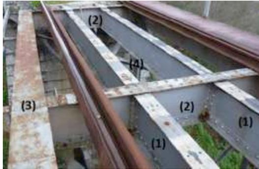
Figura 2.2 – Elementos estruturais do banzo superior do tabuleiro metálico. (1) Longarinas; (2) carlingas; (3) vigas treliça; (4) contraventamentos horizontais.
