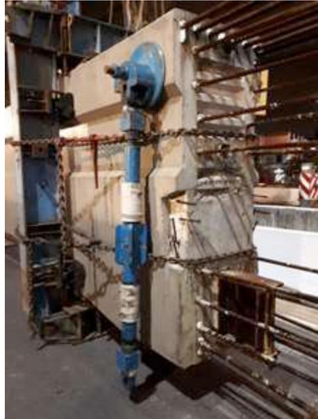
Figura 8 – Escora telescópica instalada na viga
