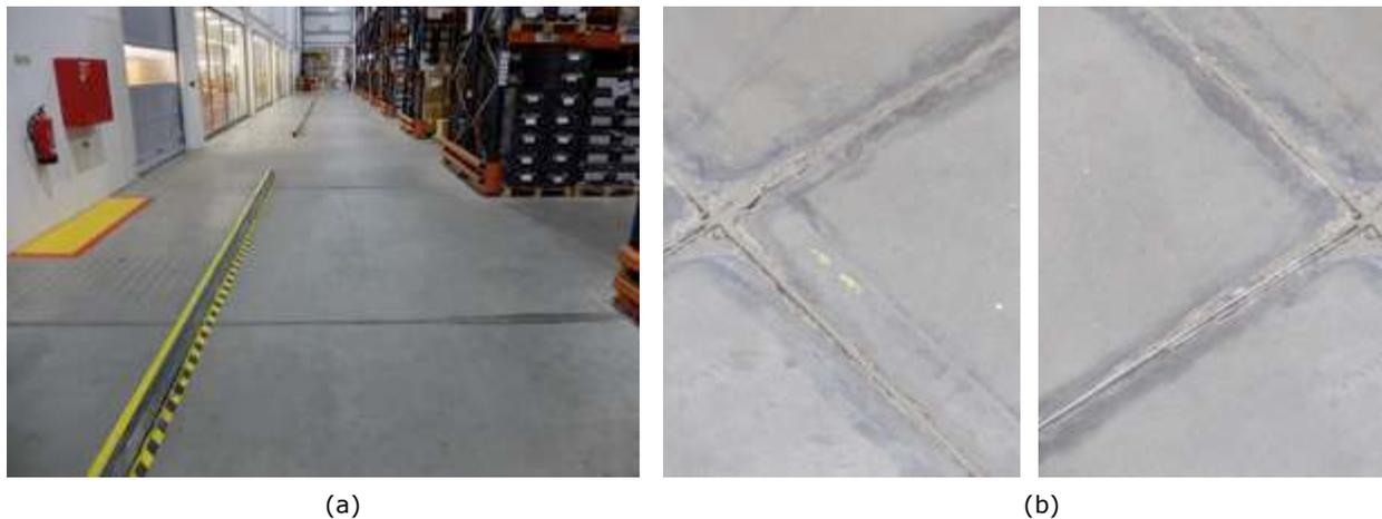
Figura 2.1 – Pavimento térreo: (a) vista geral e (b) detalhe das juntas de indução de fendas originais (esquerda) e de juntas intervencionadas à posteriori (direita)
