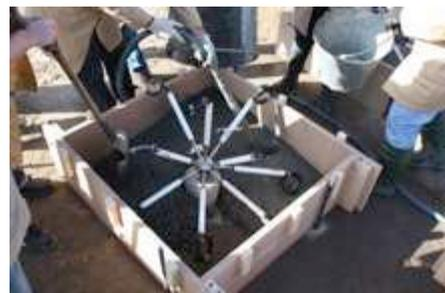
Figura 2b – Betonagem de uma roseta com nove extensómetros
