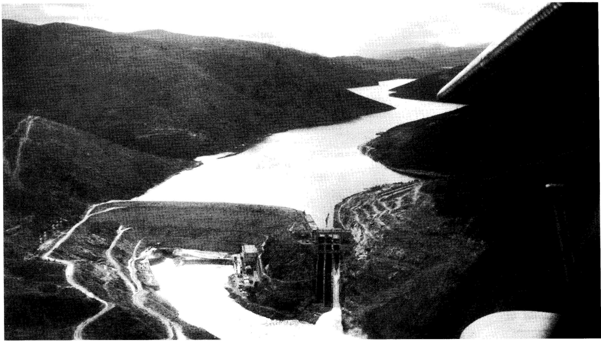
Колымская ГЭС (Магаданская обл.)
