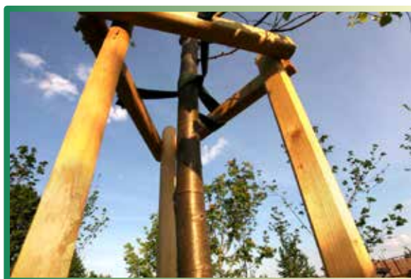
Fot.17 – palikowanie dużych drzew (Fot. W. Kamiński)
