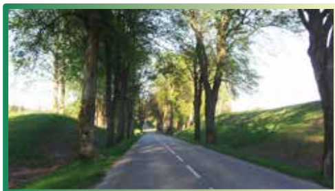
Fot.12a – drzewa rosnące w koronie drogi są niebezpieczne (Fot. W. Kamiński)
