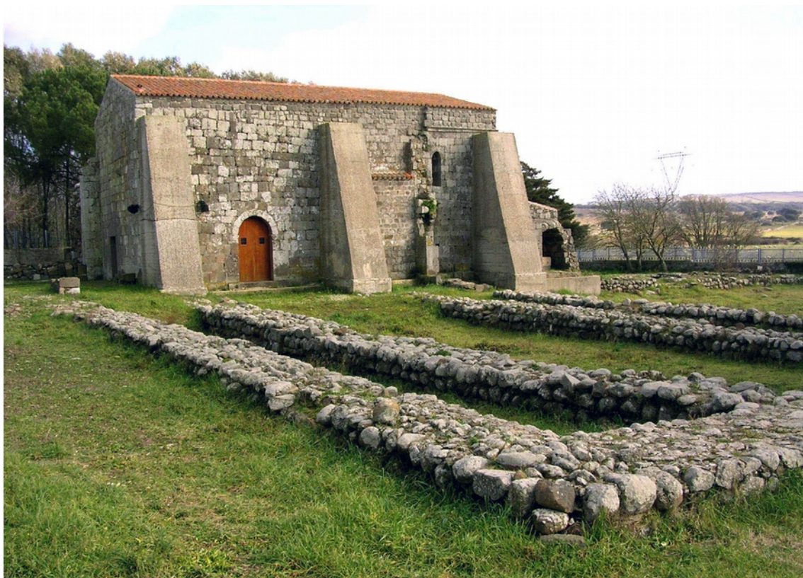
Fig. 1 - Vista da nord-ovest della chiesa di S. Maria di Cabuabbas.
