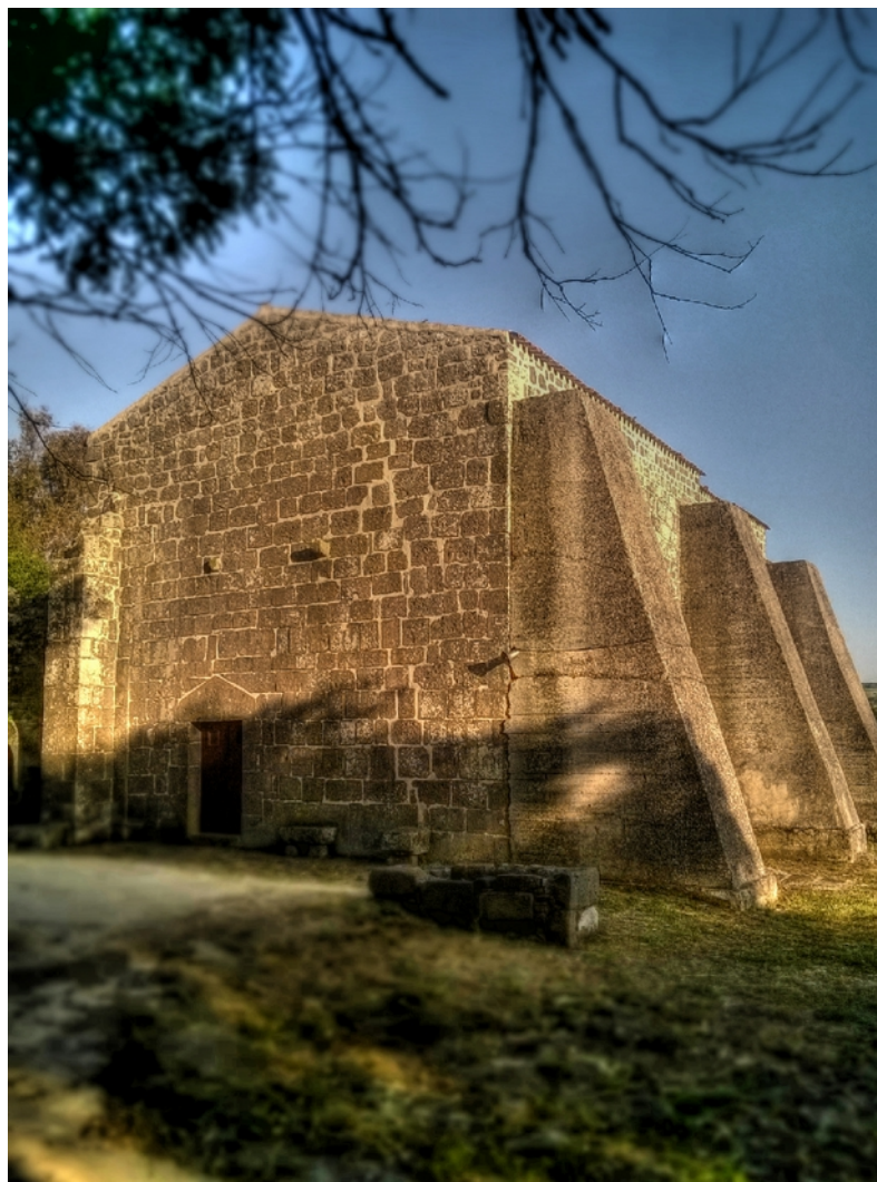
Chiesa cistercense di N. S. di Corte, dettaglio.
