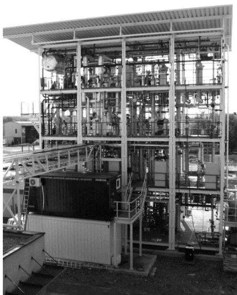
**Abbildung 2.11.** – Foto der 1 MW<sub>SNG</sub> Demonstrationsanlage (PDU) in Güssing/Österreich (Umwandlung von Holzvergaser-Produktgas zu SNG mittels Gasreinigung, Wirbelschicht-Methanisierung und Gasaufbereitung) (Foto: © PSI 2017)
