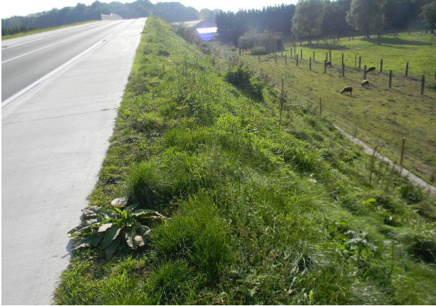
Figuur 1. De bermen van de recent voltooide spoorwegbrug in Aalter.
