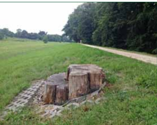
Fot. 2 (MZ) Efekt zmiany poziomu gruntu w strefie systemu korzeniowego starego drzewa. Wały przeciwpowodziowe Wrocławia w 2013 r.
