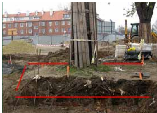
Fot. 1 (MZ) Na etapie realizacji projektu zagospodarowania terenu (PZT) i tworzenia projektu zamiennego zmieniono pierwotne rozwiązanie i zlokalizowano miejsca parkingowe bezpośrednio pod drzewem. Uszkodzono w 80% system korzeniowy drzewa. ZAMIERZENIE ZREALIZOWANO, DRZEWO OBUMIERA
