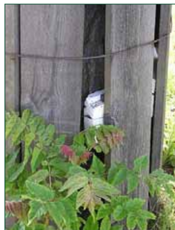
Fot. 9, 10, 11 (MZ) W przestrzeni pomiędzy skrajnią pnia a deską konieczne jest zastosowanie dodatkowego materiału (rura elastyczna PCV, styropian, otulina z pianki poliuretanowej). Warto jednak najpierw rozważyć, czy szalunek z desek będzie zabiegiem gwarantującym skuteczną ochronę drzew
