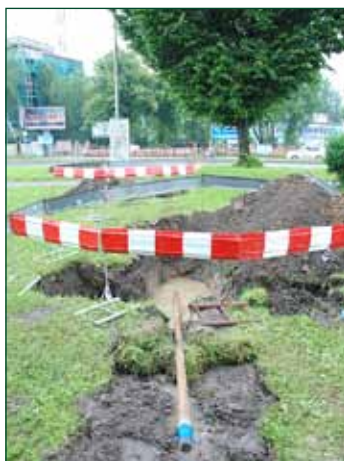
Fot. 13 (MZ) Przyjazny drzewom przewiert horyzontalny wykonany „pod” systemem korzeniowym drzewa
