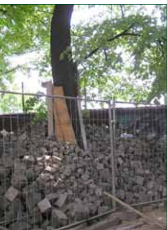
Fot. 3 (MZ) Nieprawidłowa organizacja placu budowy. Bezpośrednie zagrożenie dla kondycji drzew (zagęszczenie gruntu)
