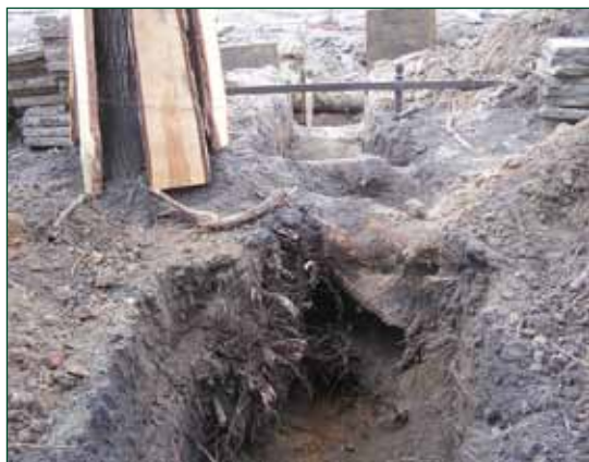
Fot. 8 (MZ) Rozmiar zniszczeń (uszkodzeń krytycznych systemu korzeniowego) przy jednoczesnym zastosowaniu szalunku z desek. W protokole kierownik budowy zapisał: „drzewa prawidłowo zabezpieczone”
