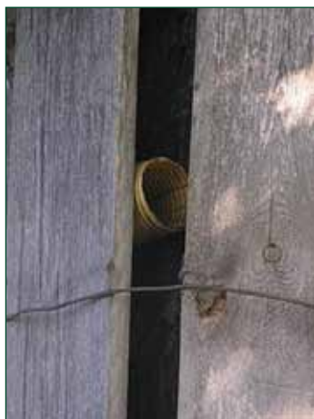
Fot. 9, 10, 11 (MZ) W przestrzeni pomiędzy skrajnią pnia a deską konieczne jest zastosowanie dodatkowego materiału (rura elastyczna PCV, styropian, otulina z pianki poliuretanowej). Warto jednak najpierw rozważyć, czy szalunek z desek będzie zabiegiem gwarantującym skuteczną ochronę drzew
