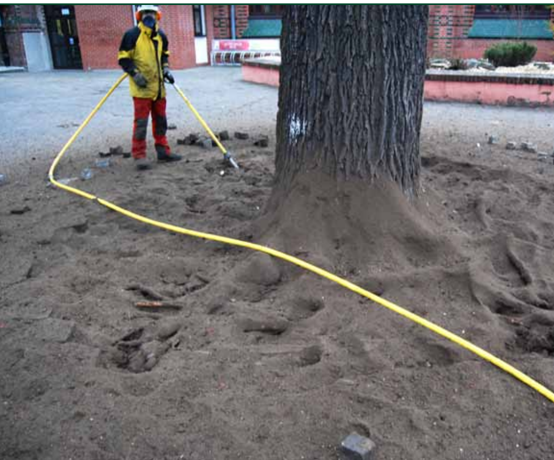
Fot. 17 (MM) Wykonanie rozluźnienia gleby za pomocą urządzenia Air Spade
