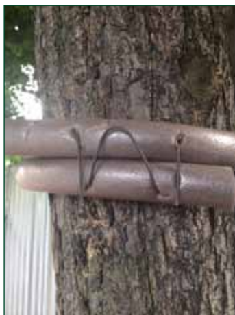
Fot. 9, 10, 11 (MZ) W przestrzeni pomiędzy skrajnią pnia a deską konieczne jest zastosowanie dodatkowego materiału (rura elastyczna PCV, styropian, otulina z pianki poliuretanowej). Warto jednak najpierw rozważyć, czy szalunek z desek będzie zabiegiem gwarantującym skuteczną ochronę drzew
