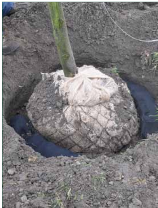
Ryc 35. Zastosowanie geokompozytu podczas sadzenia drzew alejowych, Wrocław 2013 (źródło: http://geotabo.com/galerie/ )
