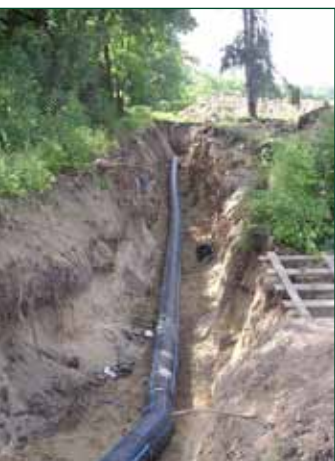
Fot. 12 (MZ) Długo otwarty wykop, obnażone, uszkodzone korzenie drzew rosnących w pobliżu
