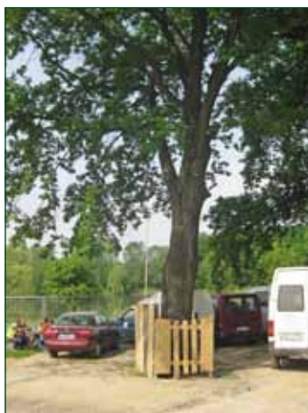
Fot. 4 (MZ) Nieprawidłowo zabezpieczone drzewo na placu budowy – niewygradzona strefa ochrony systemu korzeniowego
