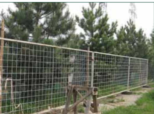
Fot. 6 (MZ) Prawidłowo wygradzone trwałym ogrodzeniem drzewa w trakcie prowadzonych prac
