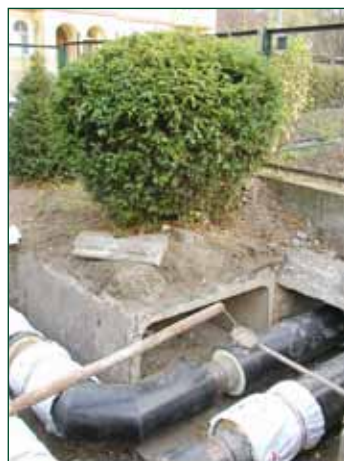
Fot. 14 (MZ) Zaskakujące „sąsiedztwo”. Cis rosnący na ciepłociągu wykonanym w starej technologii w 40 cm warstwie gleby
