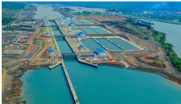
Figura 1. Vista aérea de la esclusa de Cocolí del Canal de Panamá [19]
