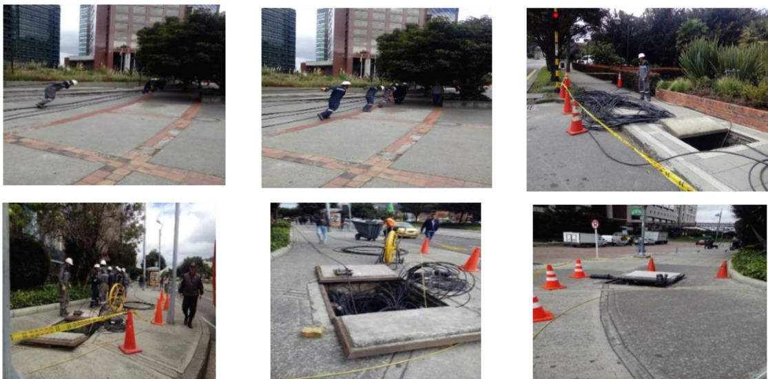
Figura 2. Tendido de FO terrestre [4]
