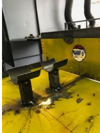
Figura 11. Soportes del tubo del intercambiador y placa de acero
