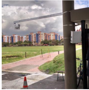
Figura 7: Equipo instalado en un acceso vehicular
