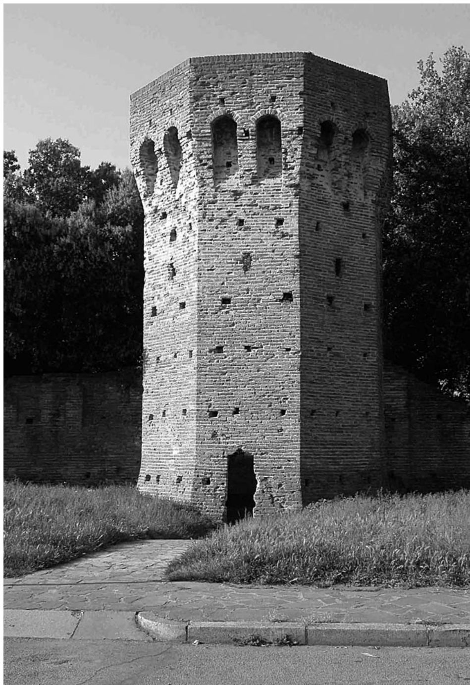
Fig. 5. Torre delle mura di fine XV secolo in via Madonna della Scala, borgo S. Giuliano (Foto N. Leoni)
