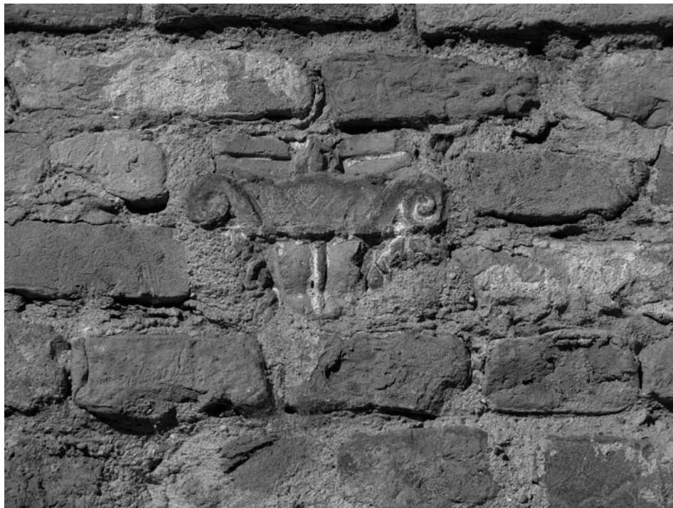
Fig. 10. Elemento architettonico di reimpiego nel paramento interno delle mura in via D’Azeglio (Foto N. Leoni)
