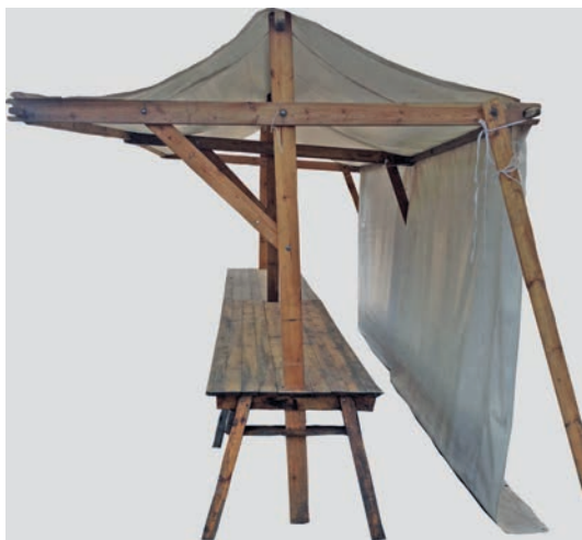
ABB. 49 | Modernes Beispiel eines temporär aufgebauten Marktstandes in Berlin: Die vorgefertigten Elemente eines Standes lassen sich dank standardisierter Maße nicht nur mit Steckverbindungen schnell auf- und abbauen, sondern ebenso in Einzelteile zerlegt platzsparend aufbewahren.
