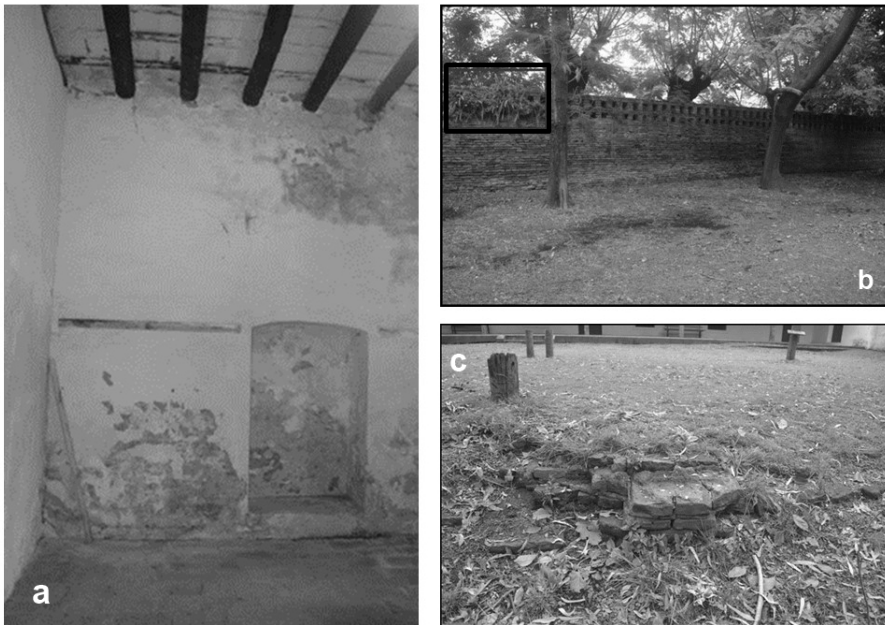
Figura 3. a. Interior de una de las habitaciones en la actualidad; b. presencia de helechos y plantas sobre el muro del palomar; c. recuperación del muro del frente de la casona.
