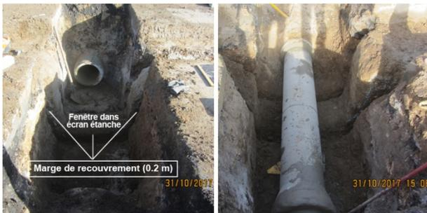
FIGURE 6 : PASSAGE DE CANALISATION BÉTON
