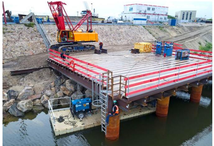
FIGURE 12 : QUAI ET RAMPE DE CHARGEMENT PROVISOIRE EN COURS DE MISE EN PLACE
