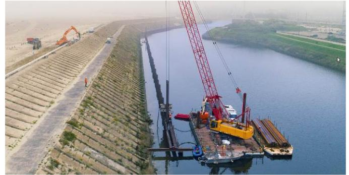
FIGURE 14 : MISE EN ŒUVRE DES PALPLANCHES PAR VOIE FLUVIALE
