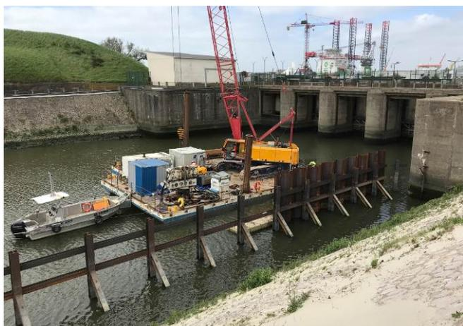
FIGURE 16 : MISE EN PLACE PAR MOYENS SUBAQUATIQUES DE LA STRUCTURE MECANO-SOUDEE AU DROIT DU RADIER DE TIXIER
