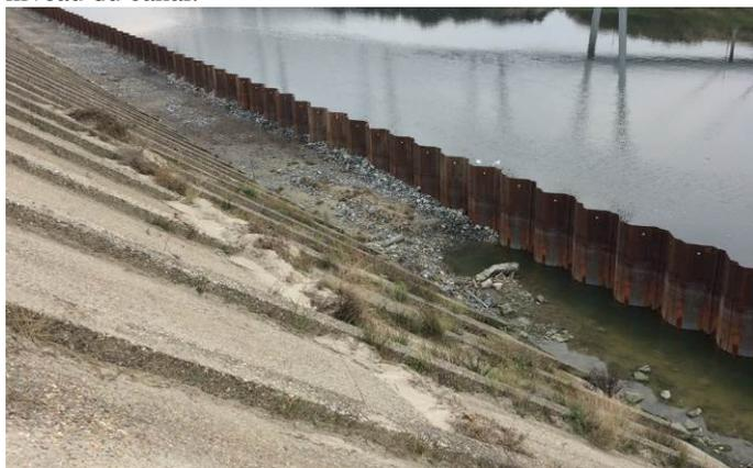
FIGURE 18 : FILTRE ET DRAIN PHASE 1 ; REALISATION DE LA PISTE
