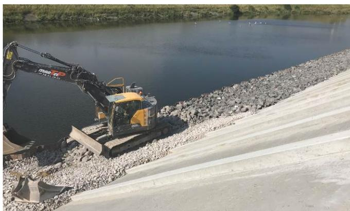
FIGURE 19 : FILTRE ET DRAIN PHASE 2 ; REALISATION DE LA PARTIE SUPERIEURE, Y COMPRIS PROTECTION EN ENROCHEMENTS
