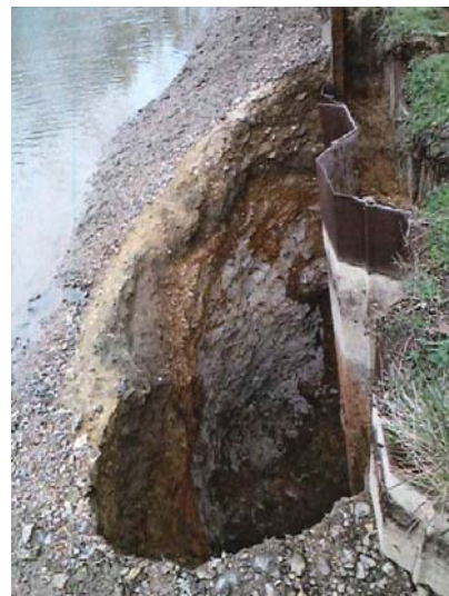
FIGURE 13 : OUVERTURE DANS LA DIGUE DE 2011
