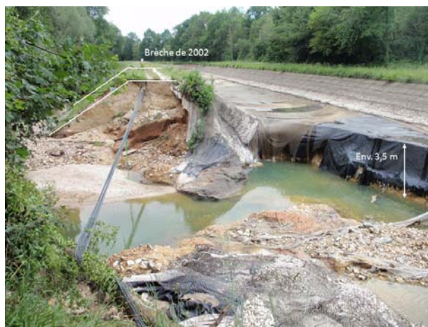
FIGURE 5 : VUE DEPUIS L'AVAL DE LA BRECHE DE 2016
