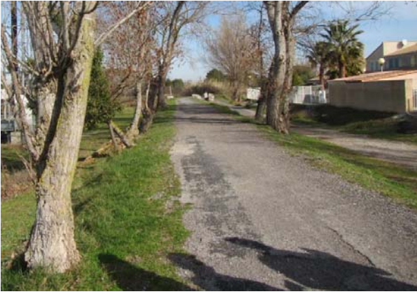
FIGURE 4 : DIGUE AVEC PISTE CYCLABLE EN CRETE
