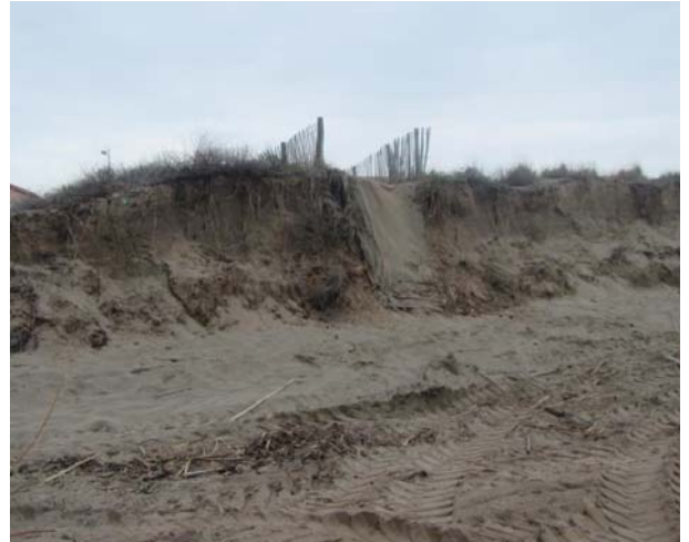
FIGURE 6 : EROSION DU CORDON DUNAIRE LORS DE L'EVENEMENT DE MARS 2018
