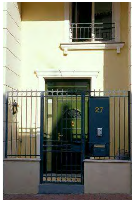
Figure 33 - Accès individualisé d'un duplex en RDC, Issy les Moulineaux, Immobilière d'Ile de France
