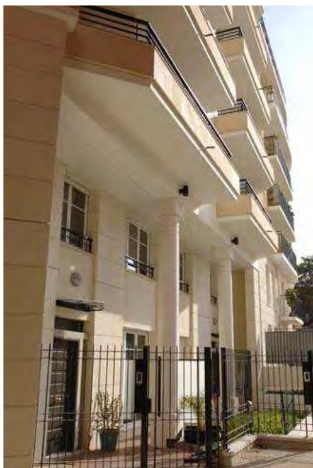
Figure 34 - Pied d'immeuble avec duplex en RDC, Montrouge, Immobilière d'Ile de France
