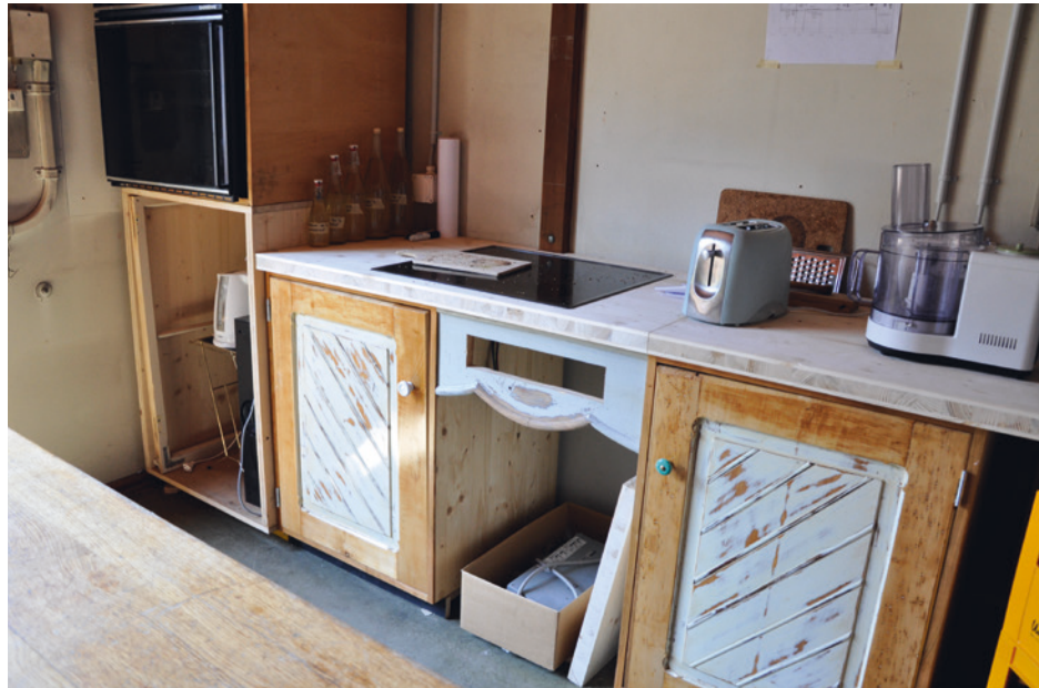
Abbildung 14: Euer Werkhof – Neue Küche im Umbau. (Foto: Judith Blum)
