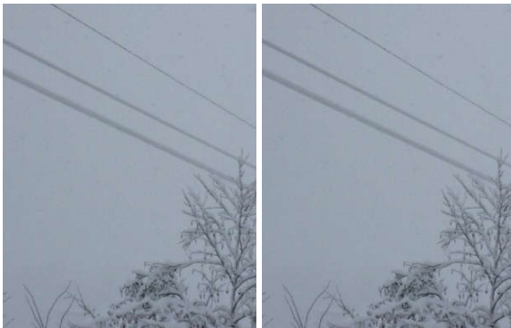
Şekil 4. Belirlenen risk sınırını aşan durumlarda iletkenlerde meydana gelen buzlanma
