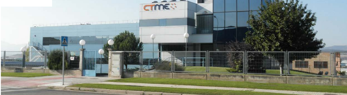
Instalaciones del CTME - Centro Tecnológico de Miranda de Ebro.
