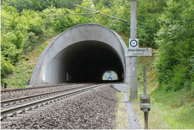
Strecke Mannheim-Stuttgart, Altenbergtunnel, Westportal (Bild: Nobbipunktcom, CC BY-SA 4.0)
