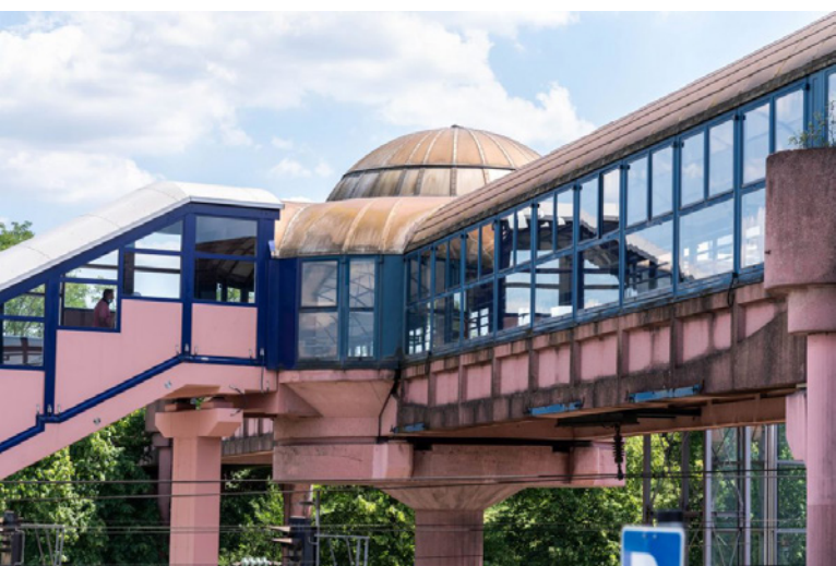
Neußheim, Verteilerebene, Außenansicht (Bild: Baden-württembergisches Landesamt für Denkmalpflege im Regierungspräsidium Stuttgart, Andreas Dubsloff)
