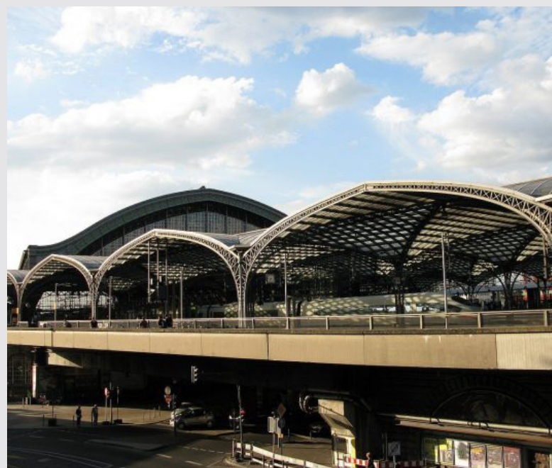
Köln, Hallenerweiterung, 2008 (Bild: photobeppus, CC BY SA 2.0)
