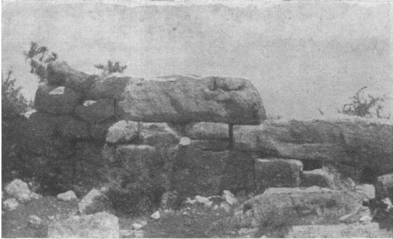
FIG. 12.—WALL AT LEONIDI.
