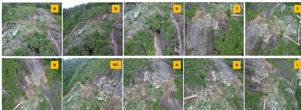
FIGURA 3 - Fotos adquiridas por drone da região de encosta do Morro do Vidigal, com detalhamento da região de contenção construída para evitar deslizamento de terra. Elaboração própria.
