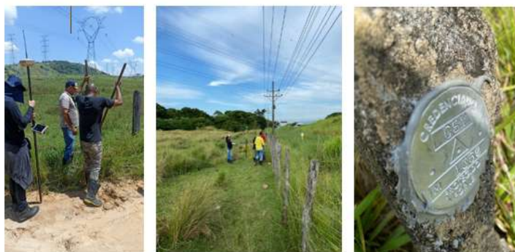
FIGURA 3 - Implantação de marcos e georreferenciamento de lotes da FNSC. Elaboração própria.
