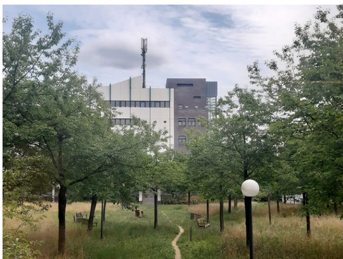
Berlin-Hellersdorf, Bürodienstgebäude (Bild: Karin Berkemann 2024)
