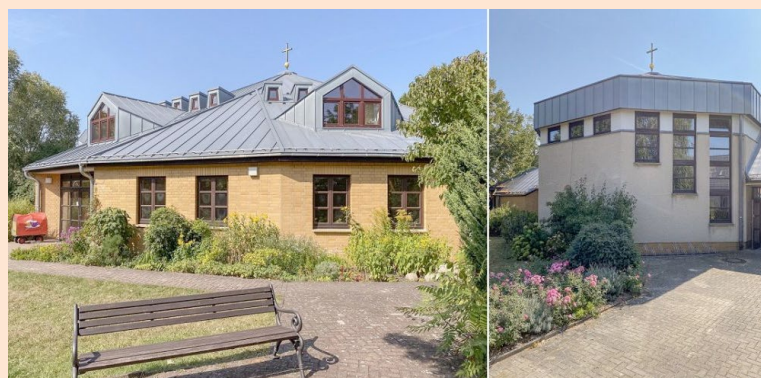
Berlin-Hellersdorf, Ev. Gemeindezentrum – der Fotograf Louis Volkmann zeigt die Fassaden einmal einladend vom Garten (links), einmal etwas hochgeknöpft von der Straße aus gesehen (Bilder: Louis Volkmann, 2024)
