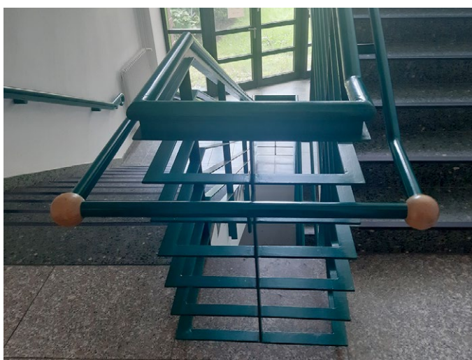
Berlin-Hellersdorf, Bürodienstgebäude (Bild: Karin Berkemann 2024)
