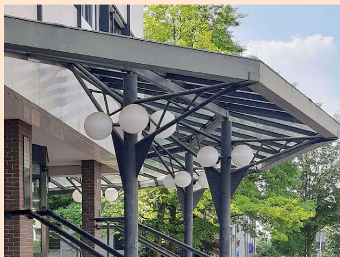
Berlin-Hellersdorf, Bürodienstgebäude (Bild: Karin Berkemann 2024)
