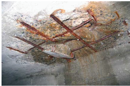
a. Corrosion
