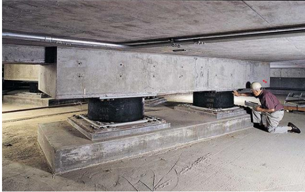
Şekil 3: Bir binada sismik izolatör kullanımı (Anonim 2024c)
