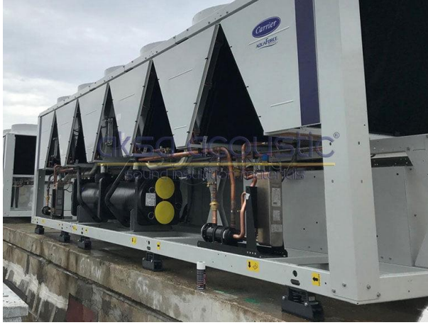
Şekil 2: Bir soğutma ünitesinde sismik izolatör kullanımı (Anonim 2024b).
