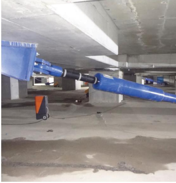
Şekil 8. Akışkan viskoz sönümleyici (viskoz damper) uygulaması (Alhan ve Hacıemiroğlu 2023)
