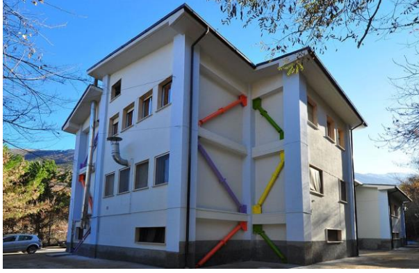
Şekil 9: Çelik histeretik damper uygulaması (Anonim 2024f)
