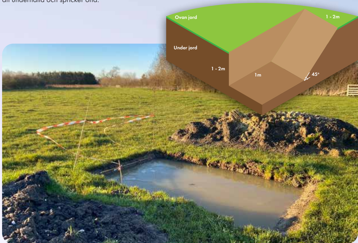
Provhål används för att bedöma en ny damms substrat och hydrologi innan anläggandet påbörjas. © Freshwater Habitats Trust
